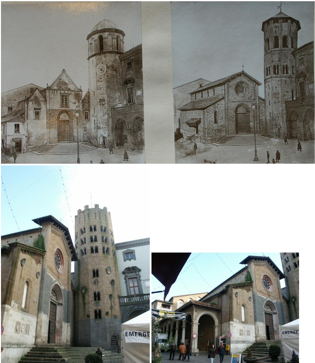
Fig. 4 Intervento sulla chiesa di S. Andrea a Orvieto (1930)
