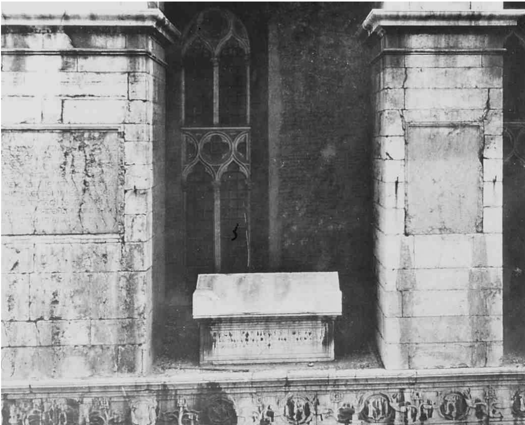
Fig. 5 Rimini: Tempio Malatestiano (metà del XV secolo); le aperture sulle pareti esterne laterali disegnate da Alberti, a ricordare una successione delle arcate degli acquedotti romani, non riprendono affatto il passo delle finestre preesistenti, seguendone uno proprio
